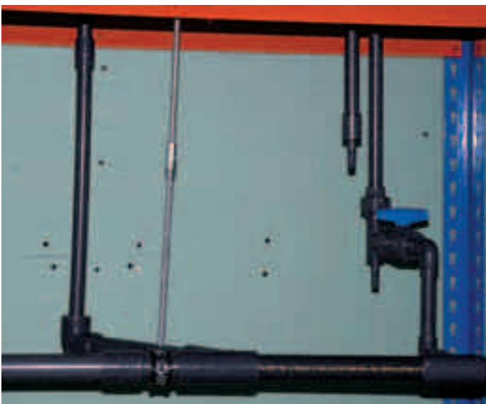
Abb. 8: Anschlüsse für den Außenfilter zur Wasserklärung. Filter connections for the water clearing.
