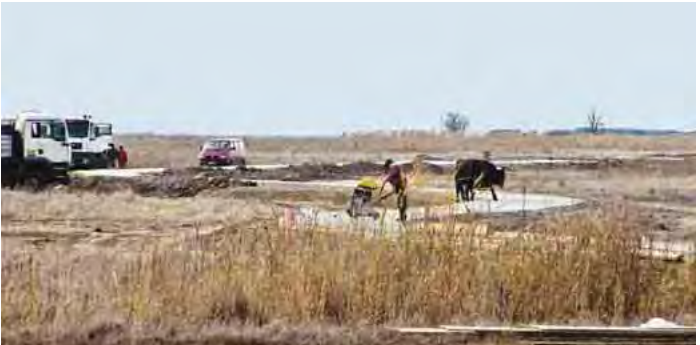
Abb. 18: Im Berichtsjahr wurde eine Zufahrtsstrasse zum Safaripark „Malomháza“ gebaut, die auch durch das Großgehege von Przewalskipferden ( Equus ferus przewalskii ), Kulanen ( Equus hemionus kulan ) und Aueroxen ( Bos primigenius f. taurus ) führt. In the last year an asphalt road to the safari park „Malomháza“ was built, which is bisecting the big enclosure of Przewalski’s horses, kulans, and aueroxes. (Foto: I. Sándor)
