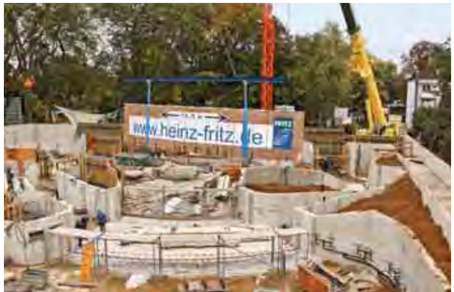
Abb. 47: Die großen Acrylglascheiben werden im Hippodrom eingesetzt. Installing the large acrylic windows in the Hippodrom. (Foto: A. Sliwa)
